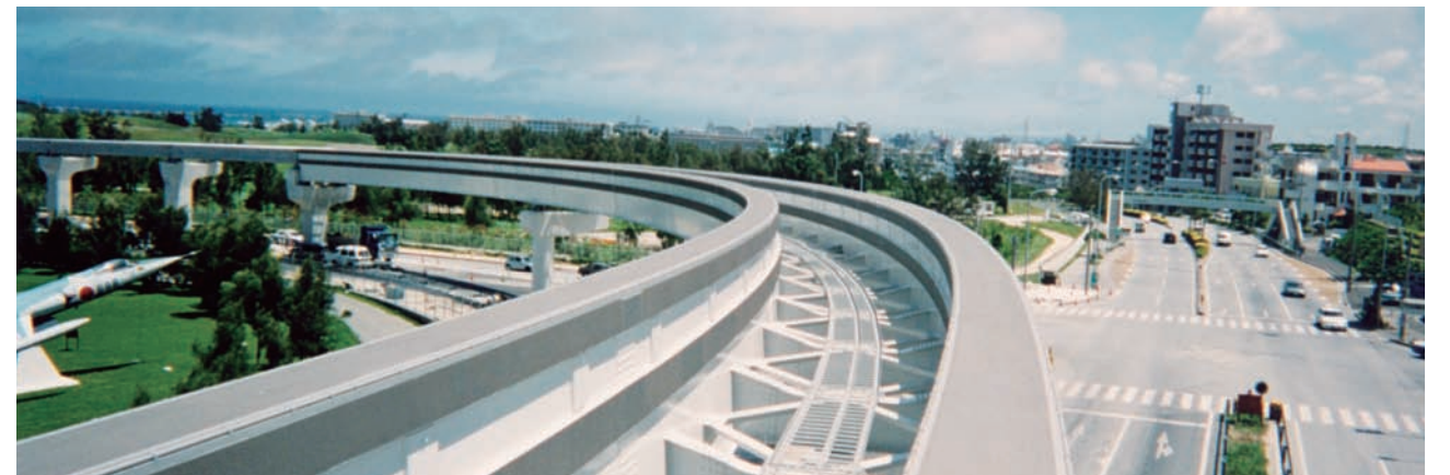
GRCブロック組込施工完了
