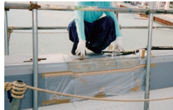
GRCブロック組込施工完了
