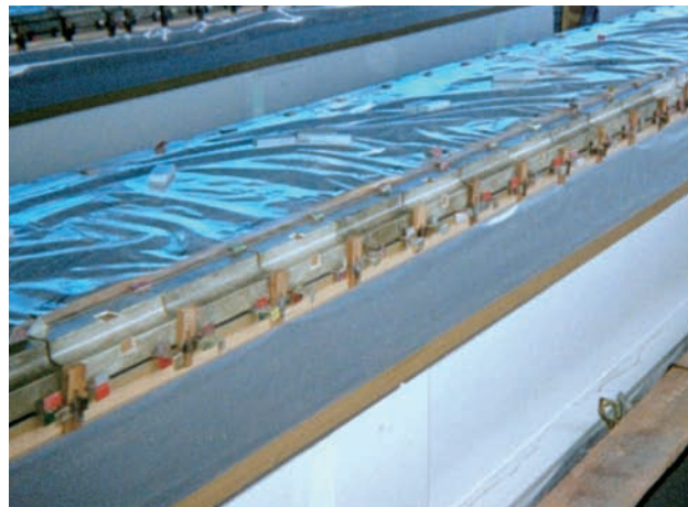
(8) GRCブロックレベル出し固定
