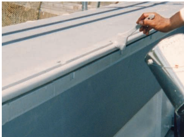
(11) 表面劣化防止材(トップF)塗装
