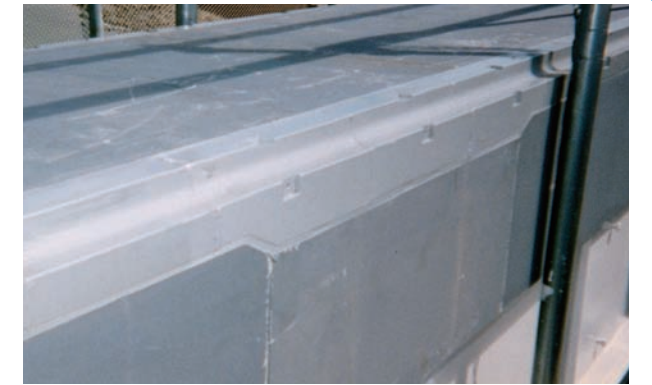
(16) 表面劣化防止材(トップF) 塗装
