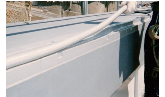
(18) 現場施工完了
