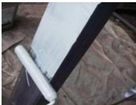
下涂涂布状况(新設)
