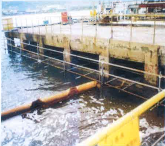
施工前(整體情況)
