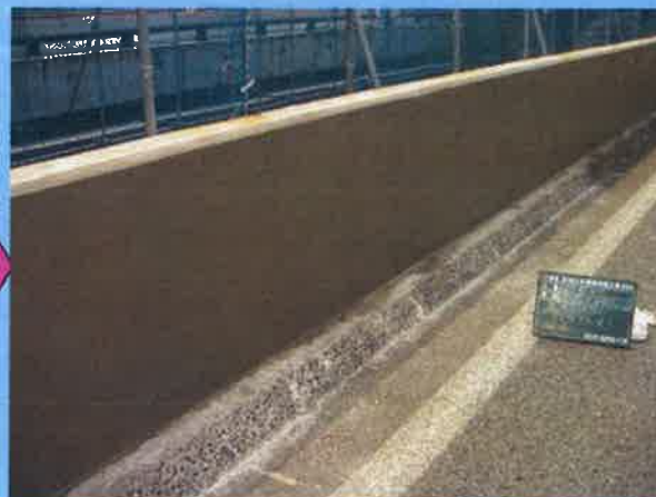
完成因應鹽害的砂漿澆置
