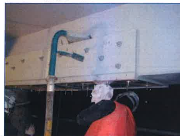
透過注入設備注入防護材料
