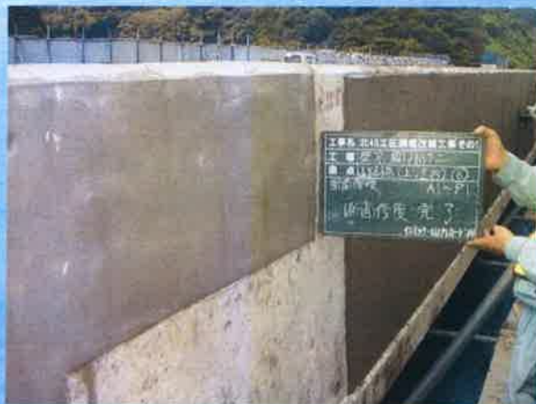
完成断面修復
