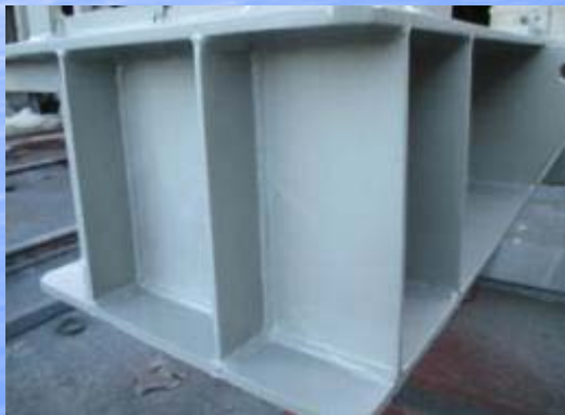
下塗材塗布状況
