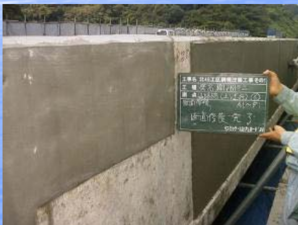
断面修復完了
