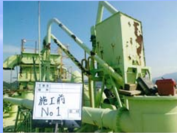
セメントサイロ 施工前
