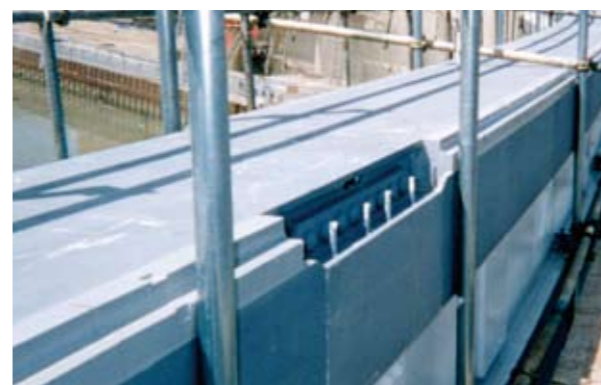
(14) GRCブロック取付
