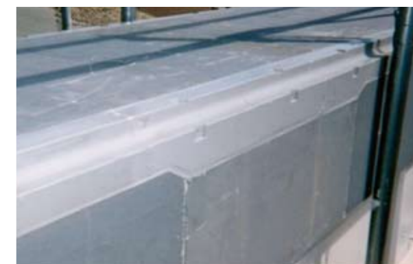
(16) 表面劣化防止材(トップF) 塗装
