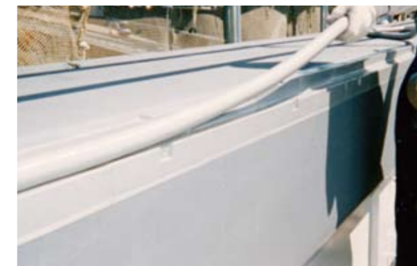
(18) 現場施工完了
