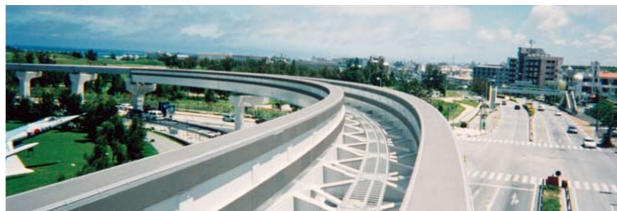
GRCブロック組込施工完了
