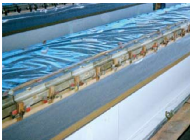
(8) GRCブロックレベル出し固定
