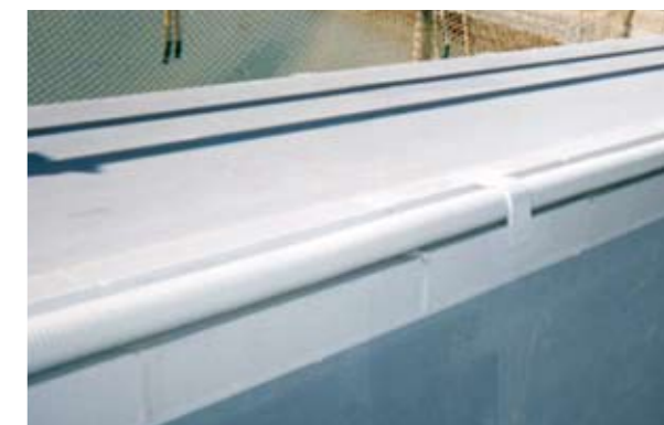
GRCブロック組込施工完了
