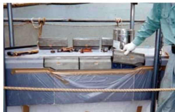
(15) 裏込注入材(U-グラウト)注入
