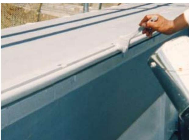
(11) 表面劣化防止材(トップF)塗装
