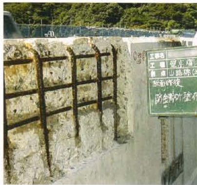
②防錆材#100塗布完了
