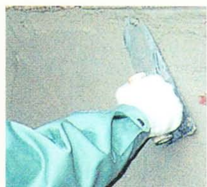
③スラググリード#400充填(構造物補修材)
