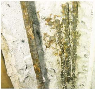
①露筋状況
