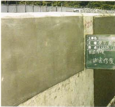
④断面修復完了
