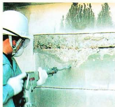
①浮き部はつり
