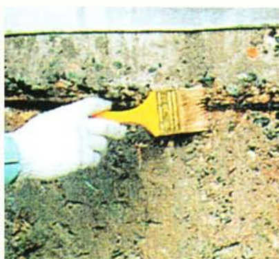
②スラググリード#100塗布(浸透防錆剤)
