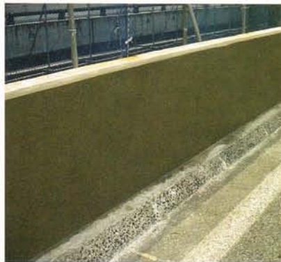
⑤塩分対策モルタル完了
