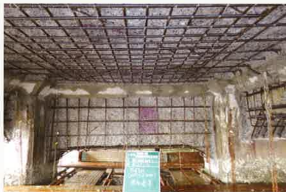
下地処理完了
