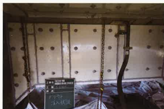
無収縮モルタル(エス・エルグラウト)注入
