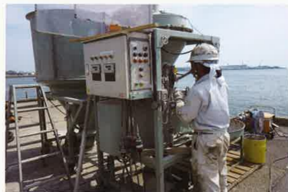
無収縮モルタル(エス・エルグラウト)配合
