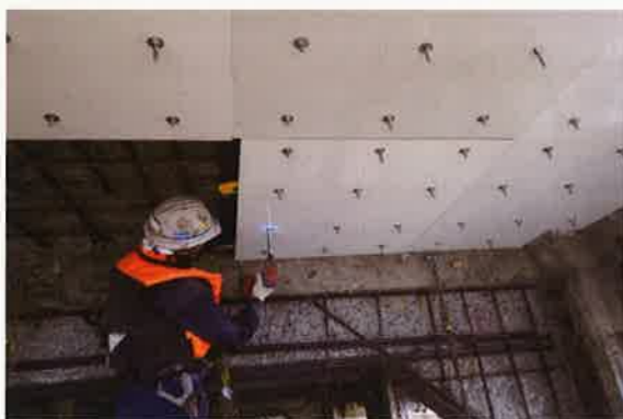
GMP板組立て(ネット締付加工)
