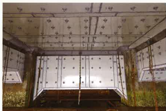
無収縮モルタル(エス・エルグラウト)注入完了
