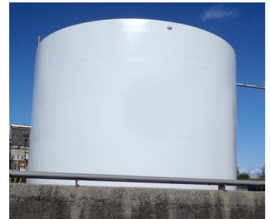
化学工場 施工後
