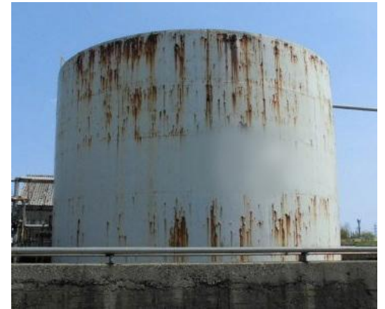
化学工場 施工前
