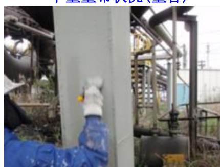
下塗塗布狀況(塗替)
