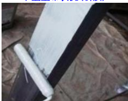
下塗塗布狀況(新設)
