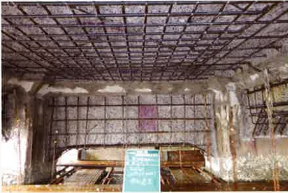
防錆処理完了
