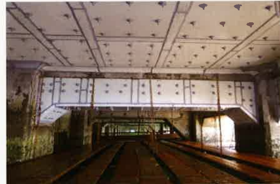
グラウト注入完了
