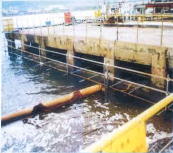
施工前(整體情況)
