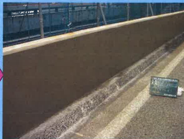
完成因應鹽害的砂漿澆置
