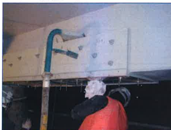
透過注入設備注入防護材料
