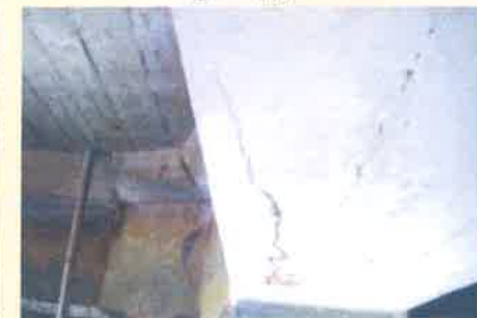
照片3 因箍筋膨脹導致的橫梁混凝土龜裂
