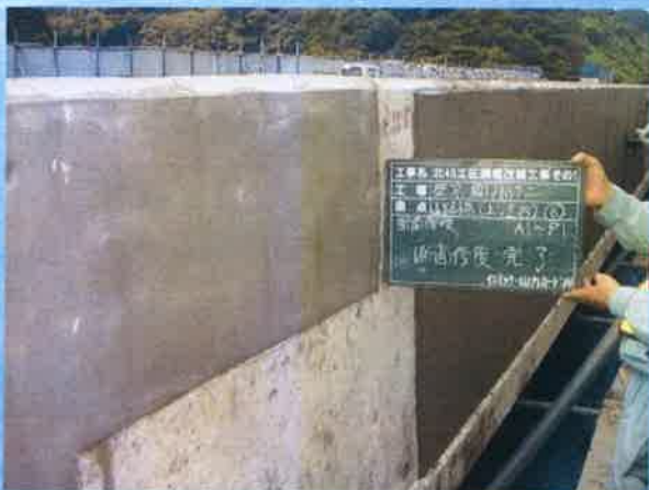
完成断面修復
