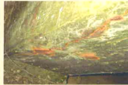
照片3 因箍筋膨脹導致的橫梁混凝土龜裂
