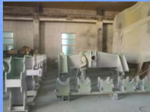
上塗材 塗装状況
