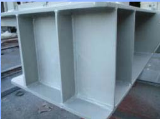
下塗材塗布状況
