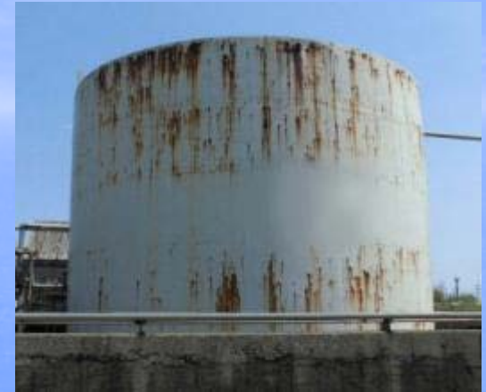
化学工場 施工前
