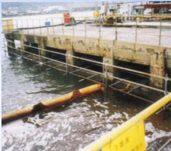
施工前(全体像)
