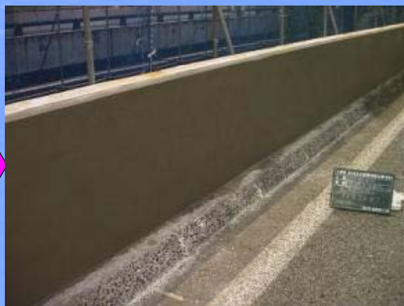
塩分対策モルタル完了
