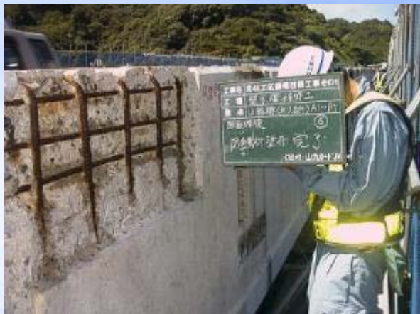
鉄筋防錆剤スラグリード#100塗布
