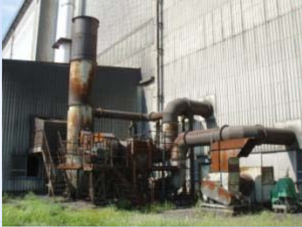
NYB 屋外排気設備 施工前
