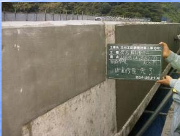
断面修復完了
