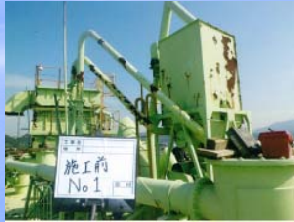
セメントサイロ 施工前
