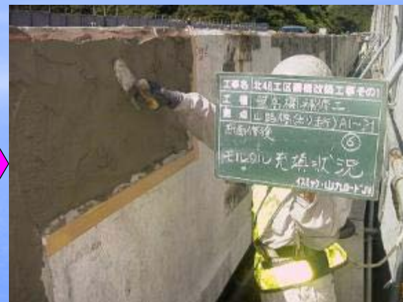
スラグリード#100・#450充填状況
