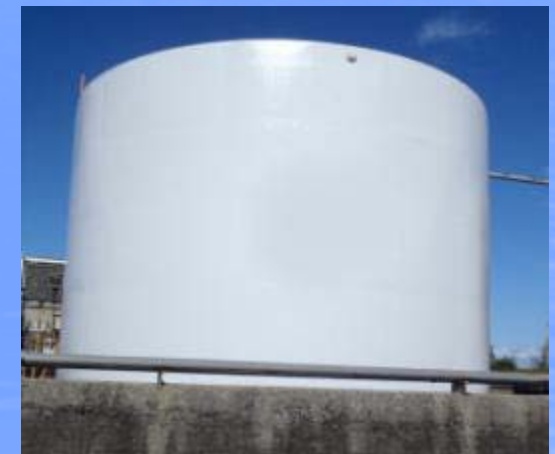
化学工場 施工後
