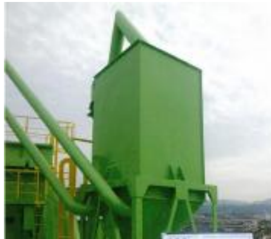
セメントサイロ 施工後
