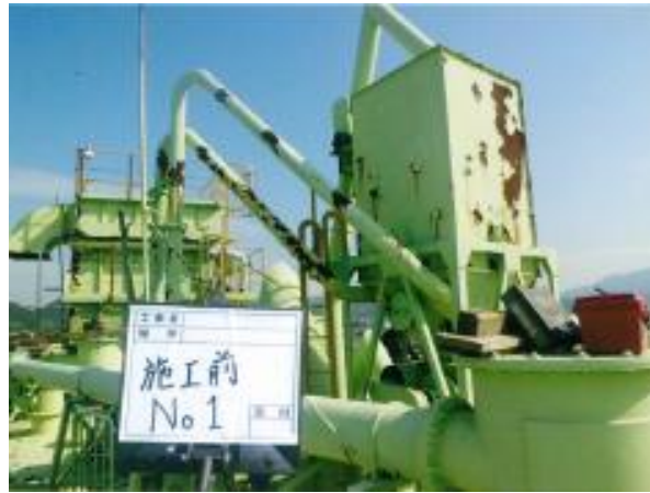
セメントサイロ 施工前
