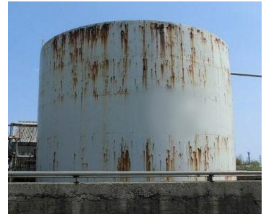
化学工場 施工前
