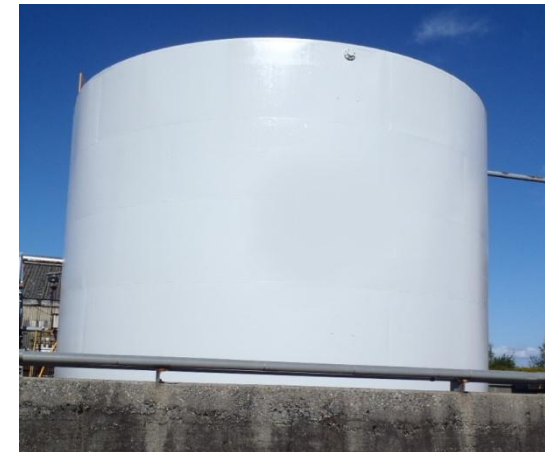
化学工場 施工後
