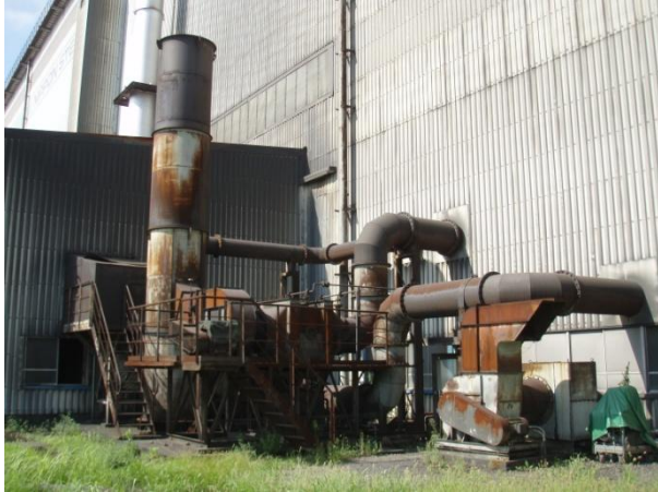
屋外排気設備 施工前
