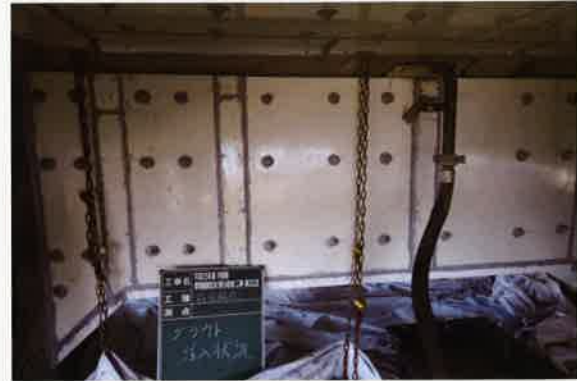
グラウト注入
