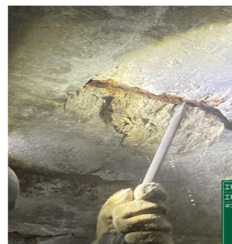
② 鉄筋ハツリ出し
