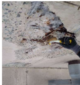
③鉄筋ケレン
