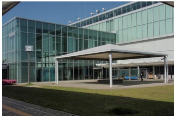
海岸沿い公共施設の骨部(3年経過)
