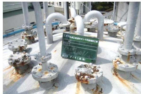
工場内プラント設備
