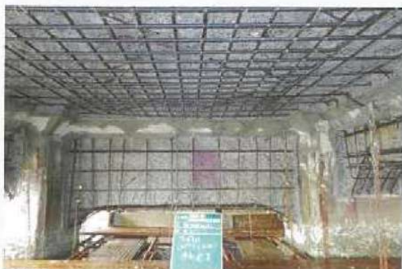
下地処理完了
