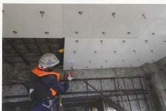
GMP板組立て(ナット締付加工)
